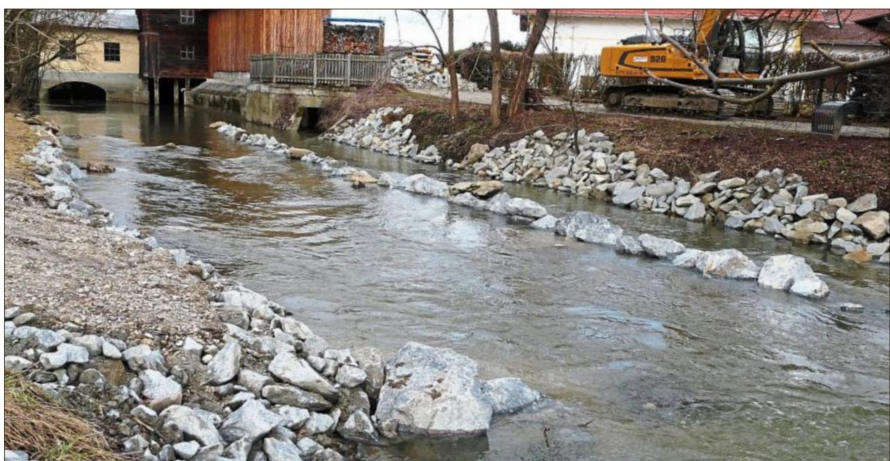
Mit einer höheren Strömung kann die Verschlammung und Verfestigung des Kieslaichplatzes vermieden oder zumindest verzögert werden.
