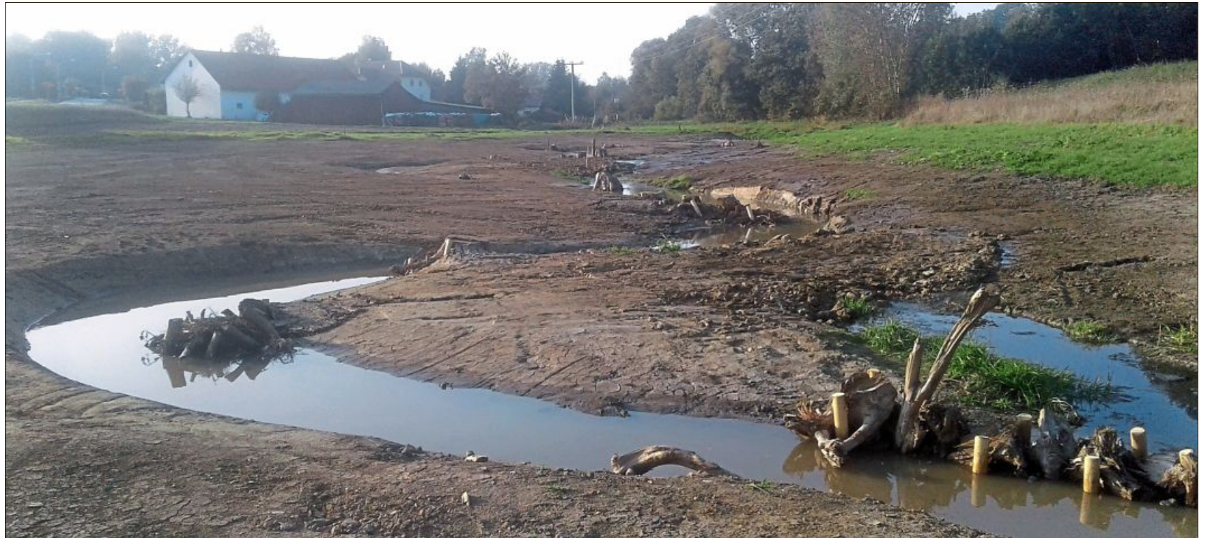
Mit der Renaturierung der Pfettrach hat sich der Lebensraum Bach zwischen Unterneuhäusen und Wehmichl erheblich verbessert: Wurzelstöcke befestigen das Ufer, unterschiedlich breite und tiefe Stellen lassen das Wasser schneller oder langsamer fließen. Foto: Naneder
