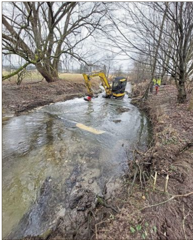
Der Flutkanal zwischen Viltsöhl und Niedermühle wurde ökologisch aufgebessert, so dass ein vielfältiger Wasserlauf für verschiedene Fischarten entstand.
