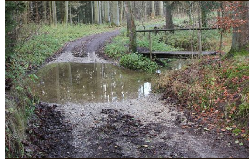
Eine Möglichkeit, die Durchgängigkeit eines kleinen Gewässers zu sichern, ist eine Furt.
