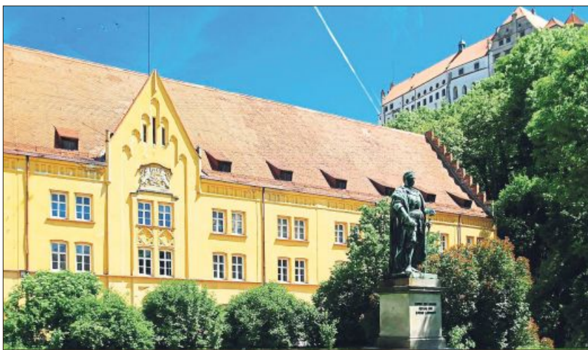
Für die Landshuter Hochzeit wurden 1475 Öffnungen in den herzoglichen Hofkasten geschlagen, damit sich die Tiere am Getreide sattfressen konnten.
